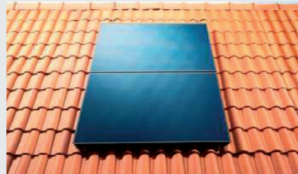
Instalação em telhado inclinado
